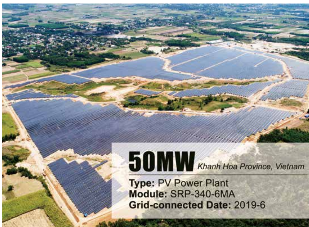
图说： 赛拉弗为越南50MW 光伏电站项目供应 组件
