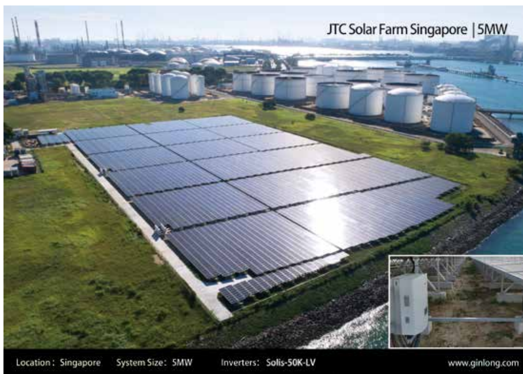
图说： 锦浪科技为新加坡 光伏项目供应逆变器
