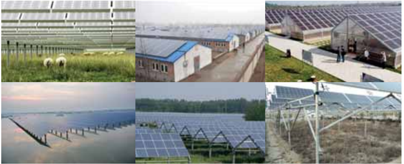
图二：常见农业与光伏的结合项目实景。左上：光伏电站生态养殖；中上：光伏养殖大棚；右上：封闭式光伏种植大棚；左下：渔光互补电站；中下：半封闭式光伏大棚；右下：可调倾角平单支架体系
