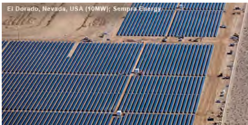
桑普拉能源在埃尔多拉多内华达安装10兆瓦First Solar 模块
